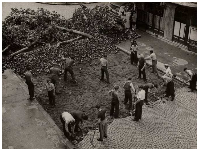
Préparation d'une barricade
